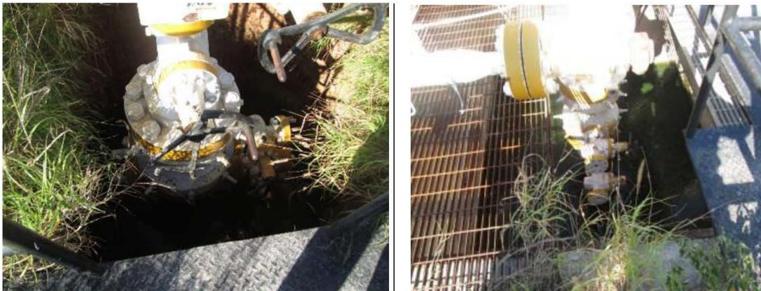
**Figura 8.4-23.-** Acumulación de agua por precipitaciones en el contrapozo del pozo PSB 201 (izquierda) y al pozo PSB 205 (derecha) Pozo sin presencia de contrapozo.
