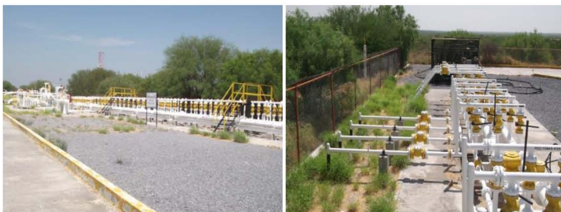
Figura 8.4-7. Inspecciones en instalaciones.
