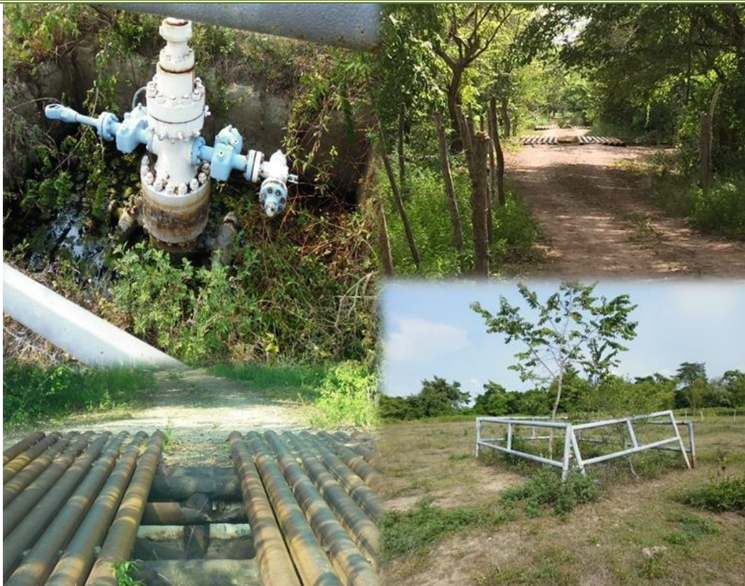
Figura 9. Pozo Mayacaste 1 y Camino de Acceso.
