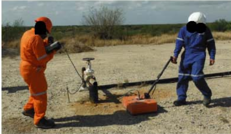
Fotografía 19. Escaneo con geo-radar GSSI-SIR 3000
