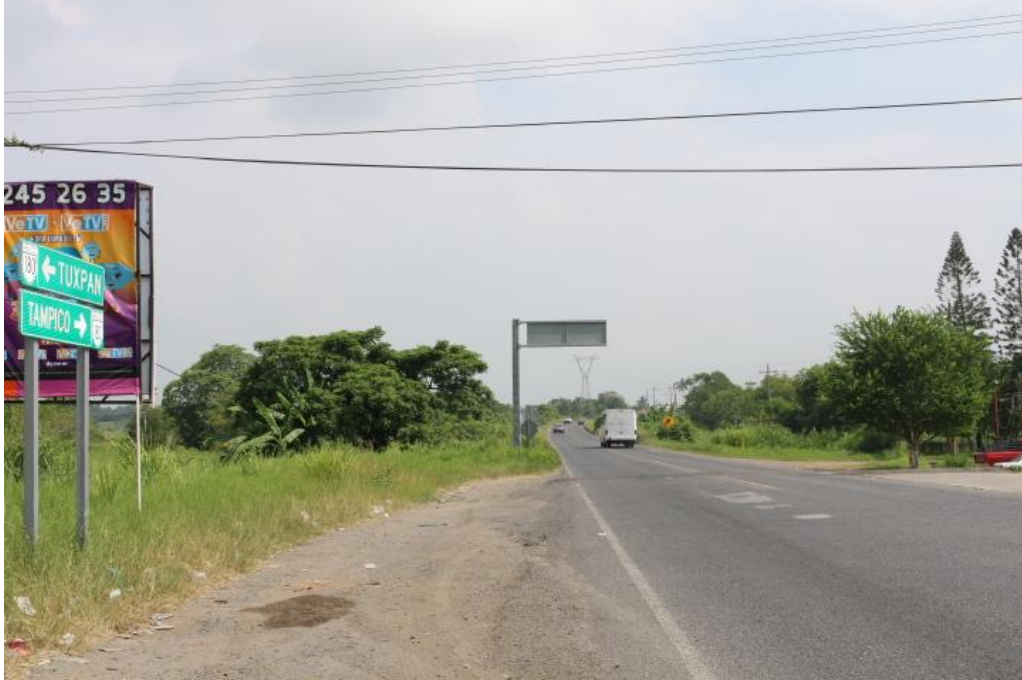
Fotografía II.2-1 Carretera Tuxpan – Tampico/ Tampico-Poza Rica/ México 180
