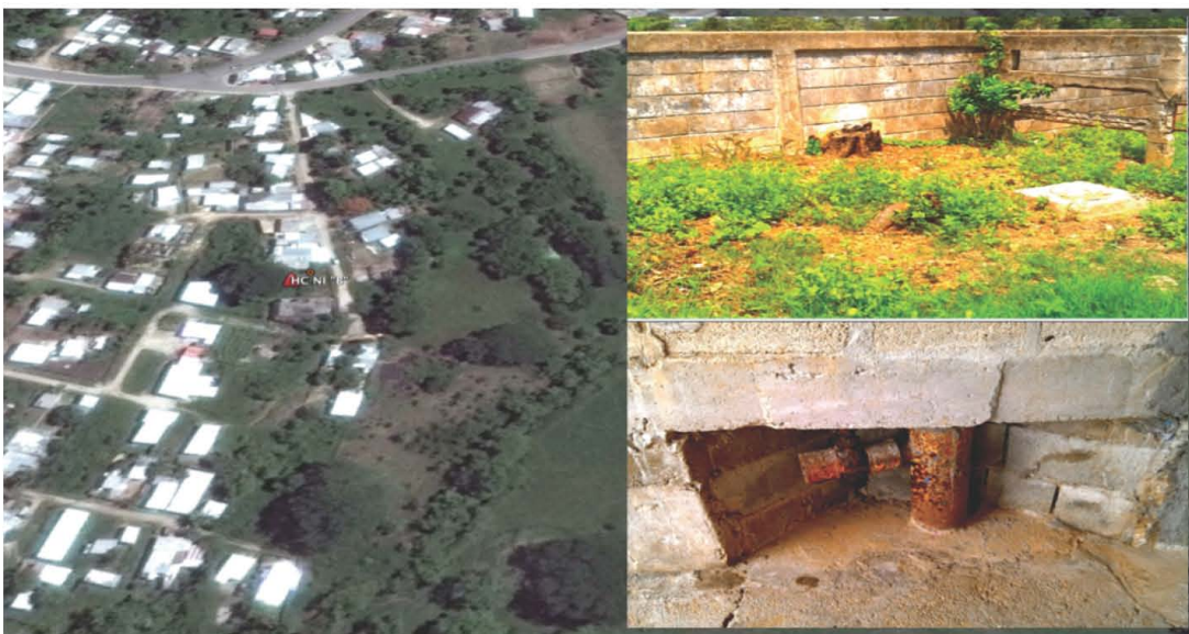
Figura VII.1.3.3. Detalle del Pozo No Identificado "B," localizado dentro de una casa habitación del Poblado de Belén.
