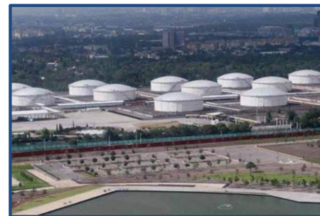
Terminal de almacenamiento y reparto de petrolíferos (México)
