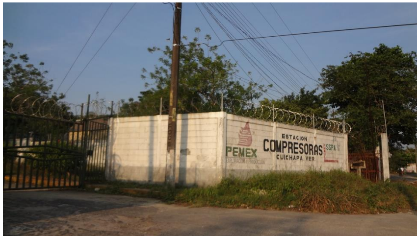
Estación Compresoras Cuichapa
