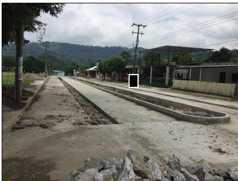
Imagen II.e-15.-Obra del Ayuntamiento donde se utiliza mano de obra agremiada.
