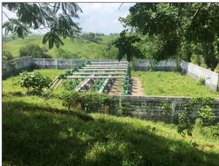
Imagen II.b-21.- Vista general del Cabezal Cathedral 15.
