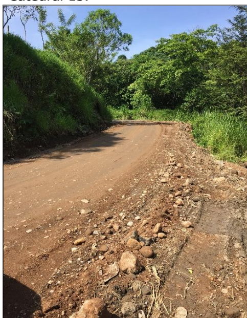
Imagen 2b.2.- Rehabilitación de carretera principal Estación Juárez – Ostucán.
