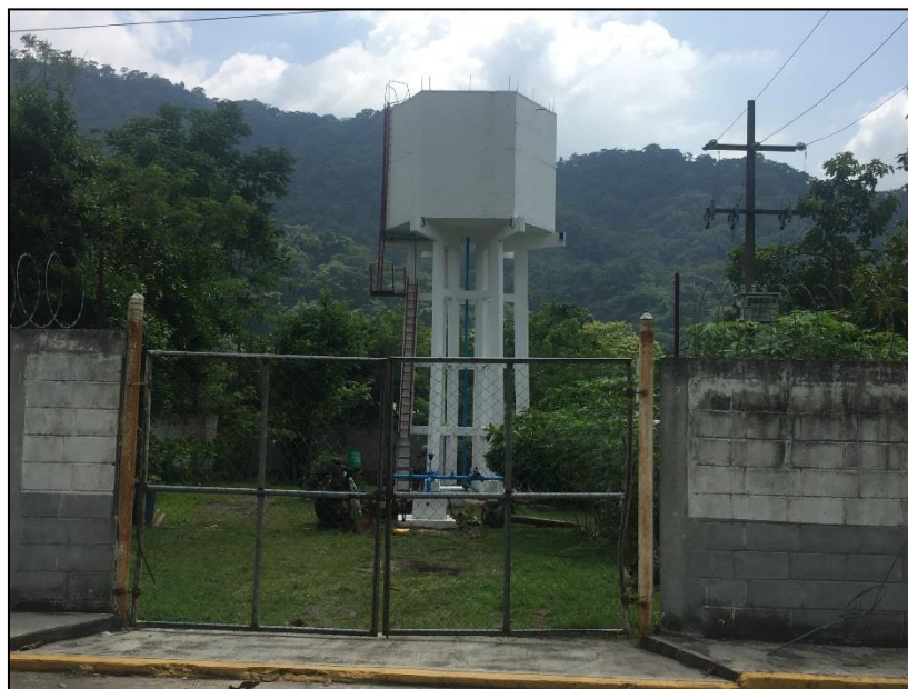
Imagen III a-5.- Pozo de agua profundo.
