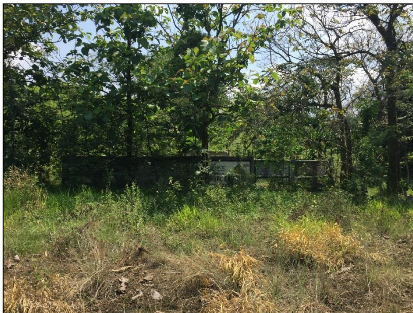
Imagen II.b-15.- Vista de la instalación del cabezal de la Macropera Catedral 41 (DL-1).
