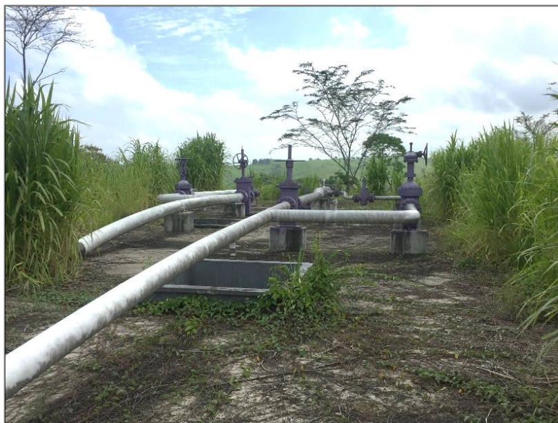
Imagen 2b.7.- Construcción de cercas perimetrales y portón de acceso en trampas de diablo de la Batería Catedral 1
