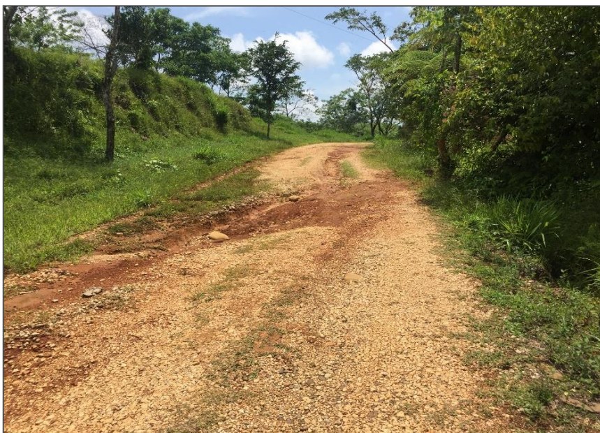
Imagen 2b.1.- Rehabilitación a camino de acceso a la Macropera Catedral 15.
