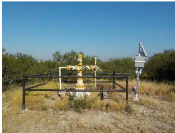
Figura 48. Cuadro de maniobras del Pozo Carretas 17 cubierto por vegetación nativa.
