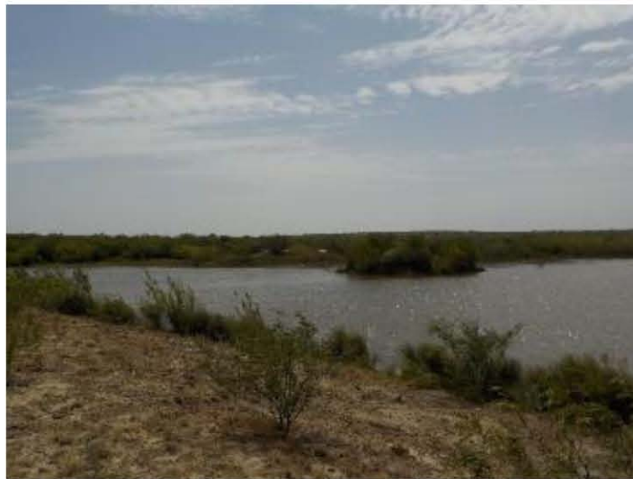
Figura 45. Presa construida como abrevadero para el ganado, con escasa vegetación herbácea debido al sobrepastoreo.
