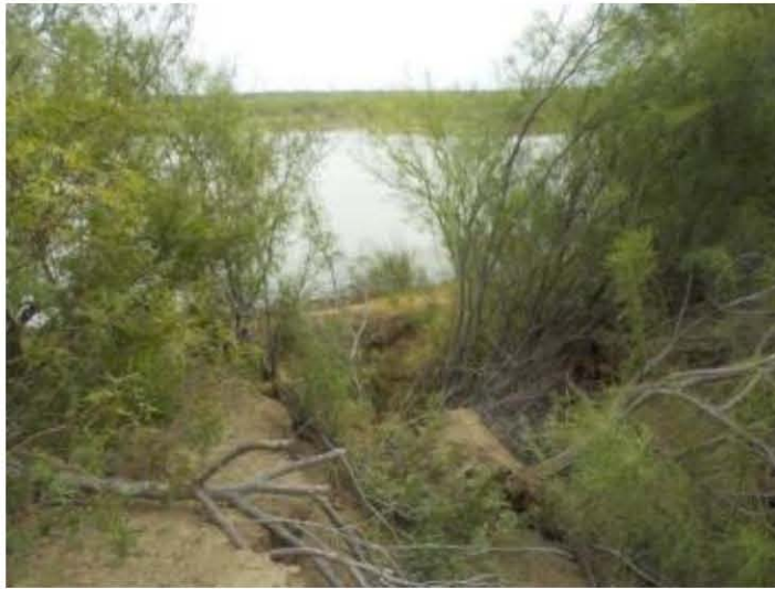
Figura 32. Presa con cárcavas en el bordo.
