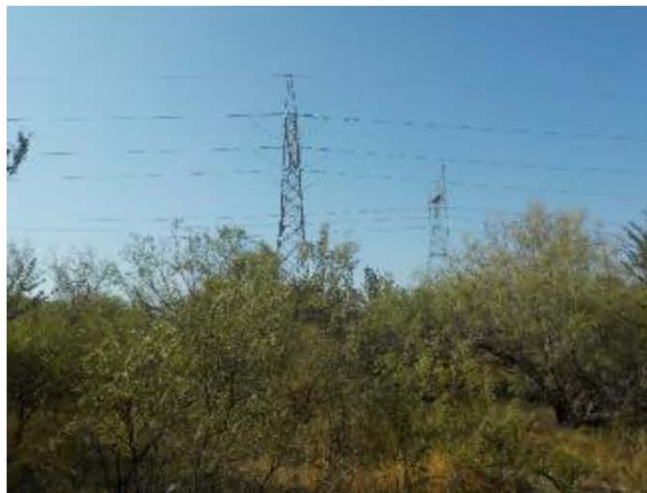
Figura 49. Torres de transmisión eléctrica afectando la calidad visual del paisaje.
