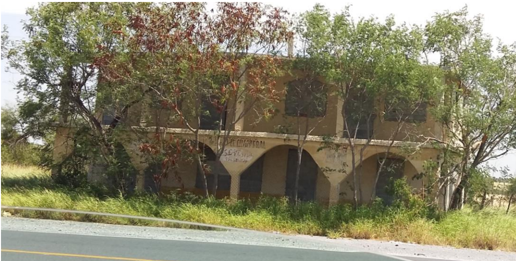
Fotografía 8. Establecimiento abandonado en Campo Carretas.
