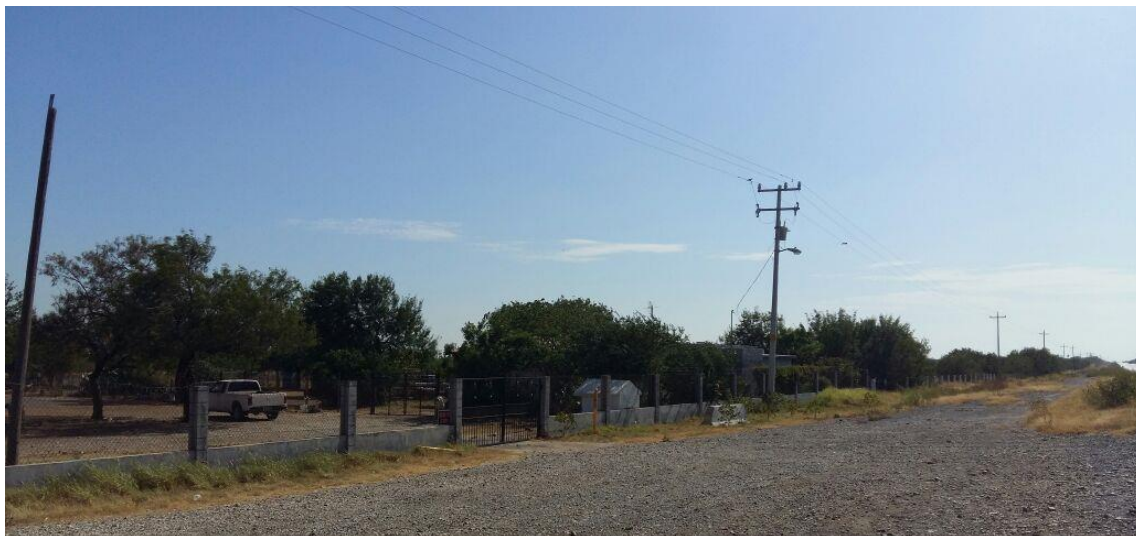
Fotografía 28. Localidad La Florida.
