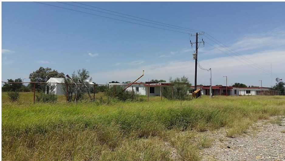
Fotografía 24. Casas abandonadas en carretera Cadereyta-Reynosa.
