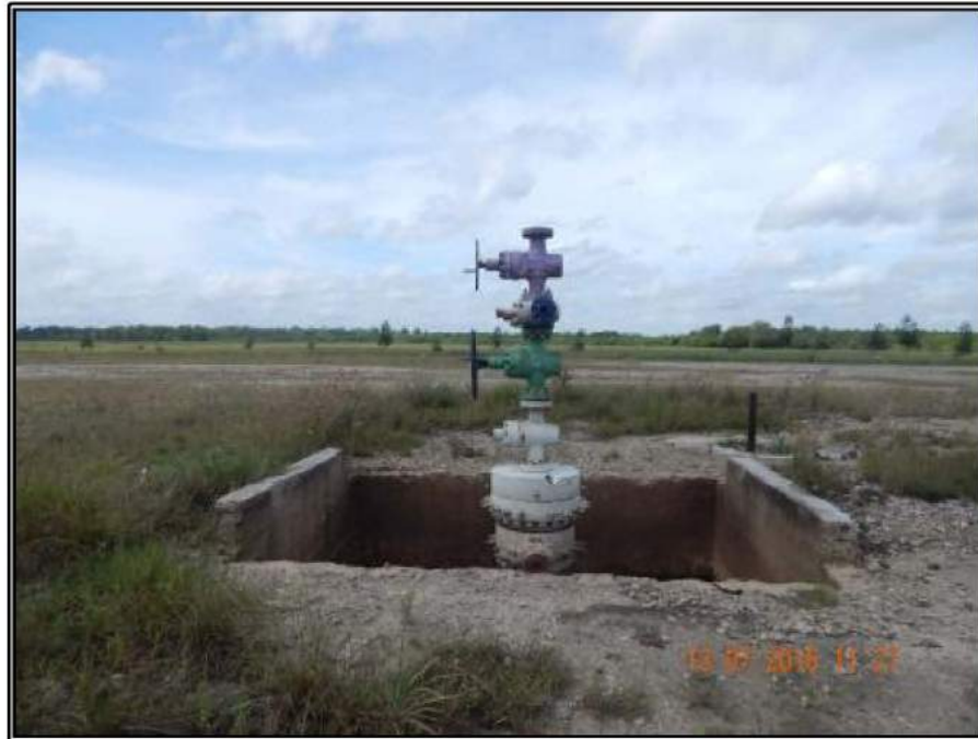
Fotografía 41.- Vista al Sur del pozo Calicanto 101.
