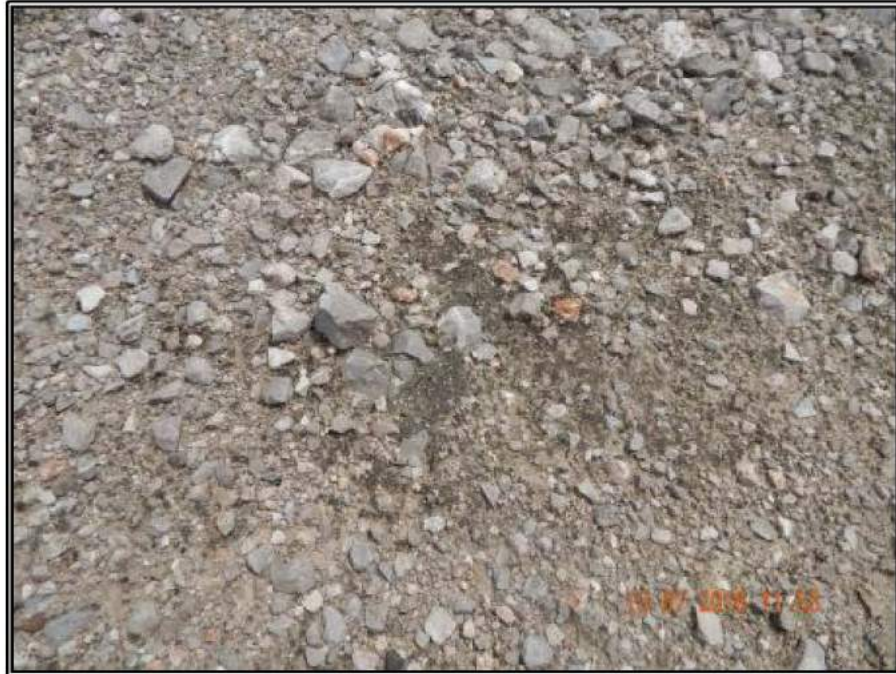
Fotografía 9.- Manchas de aceite dentro del cuadro de maniobras con superficie aproximada de .5m. En las coordenadas UTM WGS 84 X: 0424290, Y: 1978010.
