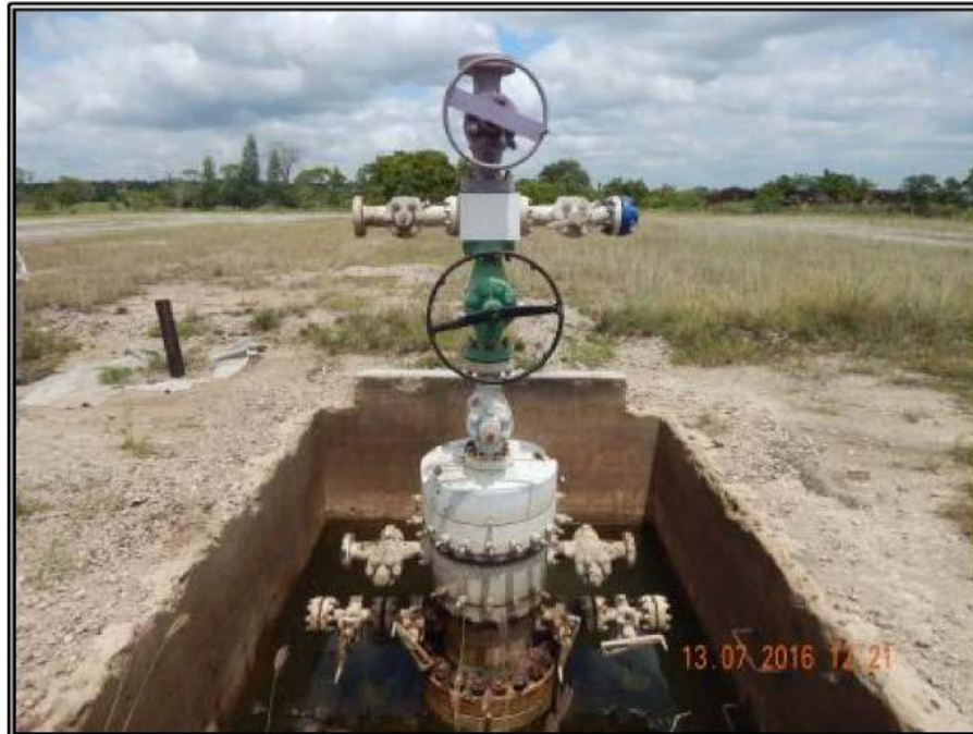
Fotografía 23.- Pozo Calicanto 101 ubicado en las coordenadas UTM WGS 84 X: 424245, Y: 1977980.
