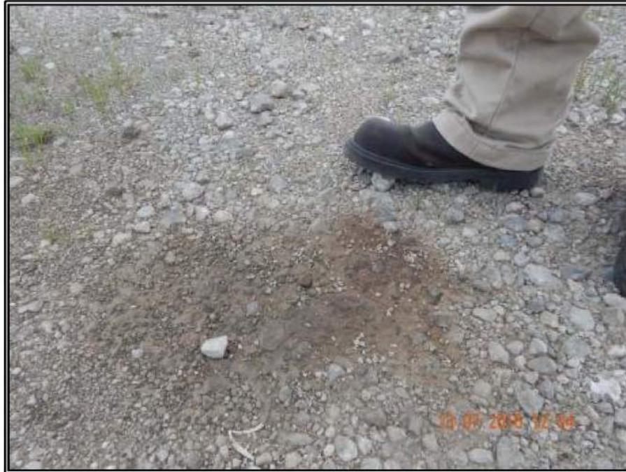
Fotografía 14.- Manchas de aceite dentro del cuadro de maniobras del pozo calicanto 101, posible indicio de motor de combustión. En las coordenadas UTM WGS 84 X: 424207, Y: 1977957.
