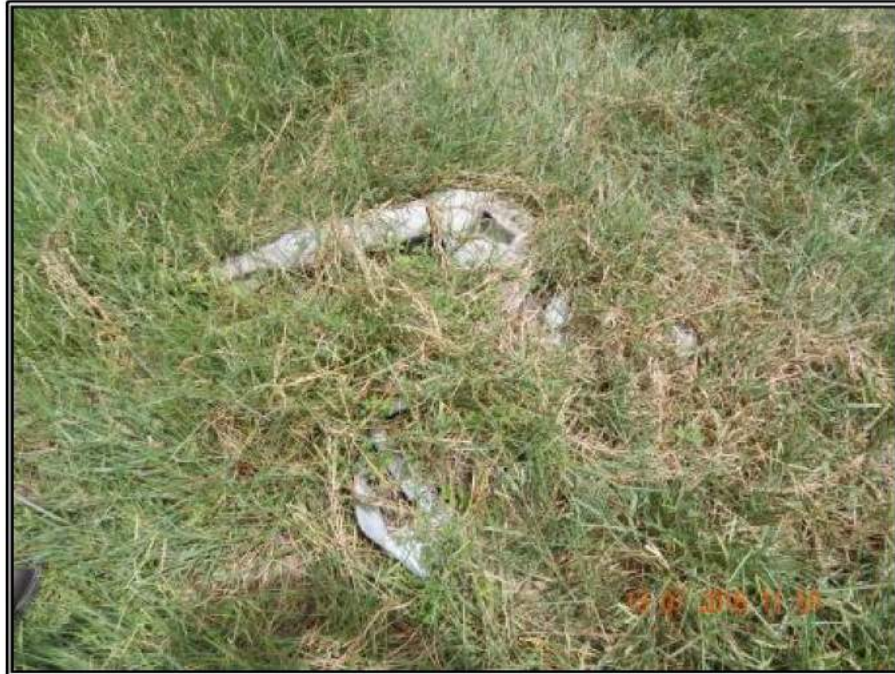
Fotografía 6.- Restos de Geomembrana dentro del cuadro de maniobras del pozo Calicanto 101. En las coordenadas UTM WGS 84 X: 0424257, Y: 1978016.
