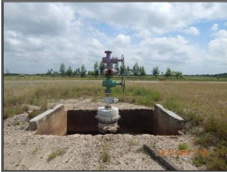
Fotografía 40.- Vista al Norte del pozo Calicanto 101.
