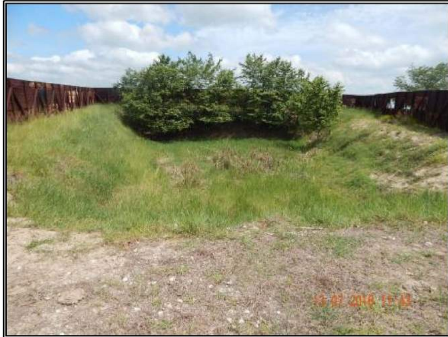
Fotografía 4.- Presa de quema en la periferia del cuadro de maniobras del pozo Calicanto 101. En las coordenadas UTM WGS 84 X: 0424147, Y: 1978021.
