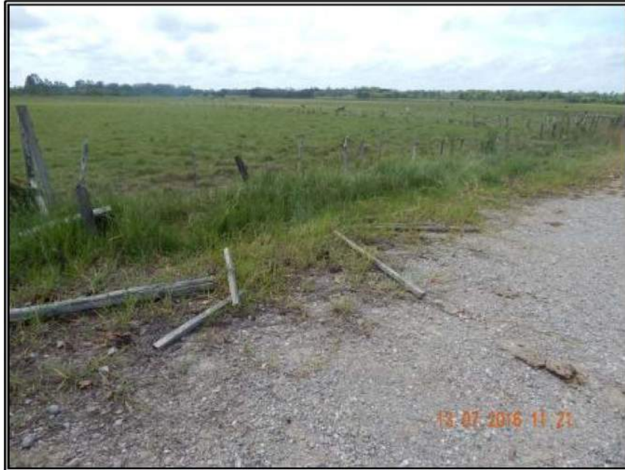
Fotografía 2.- Cercado perimetral del cuadro de maniobras incompleto, ubicada en las coordenadas UTMWGS84 X: 042430, Y: 1978013.
