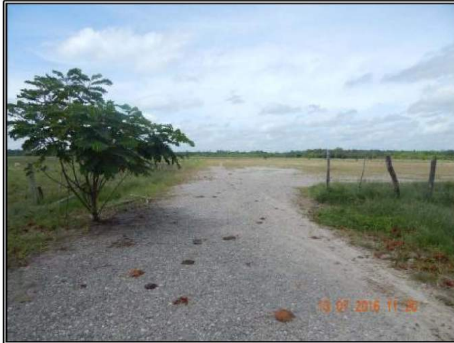
Fotografía 1.- Camino de acceso al cuadro de maniobras del pozo CALICANTO 101. Falta de señalización, Portón de acceso y Guardaganado, la cual está localizado en las coordenadas UTM WGS 84 X: 424302 Y: 1978013.
