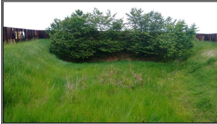
Fotografía 8.4.1-3.- Sondeo de inspección en Presas de perforación o quema.
