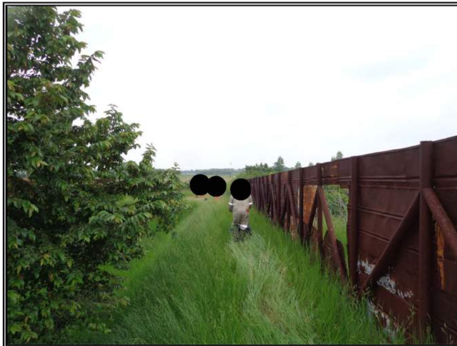
Fotografía 8.4.1-4.- Recorrido de Inspección en presa de perforación o quema.
