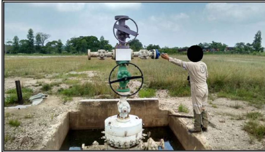
Fotografía 8.4.1-1.- Inspección en el contrapozo inundado.
