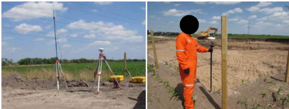
Fotografía 8.4.2-1.- Trabajos de levantamiento topográfico con estación GPS Topográfico Marca South Modelo RTK-S82T (Ejemplo tomando en Rio Bravo, Tamaulipas).
