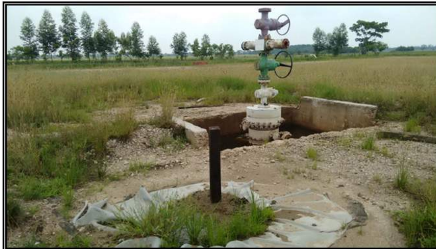
Fotografía 8.4.1-2.- Inspección en los alrededores del pozo Calicanto 101.
