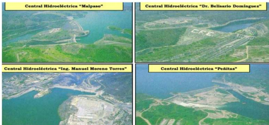
Figura 8.1.2.1-5.- Perspectiva aérea de las Centrales Hidroeléctricas ubicadas en el Complejo Grijalva.
