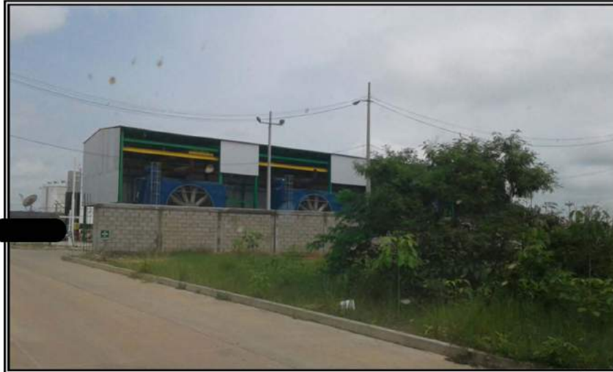
Fotografía 8.4.1-5.- Estación de PEMEX que se encuentra fuera del Área Contractual 4 Campo Calicanto.
