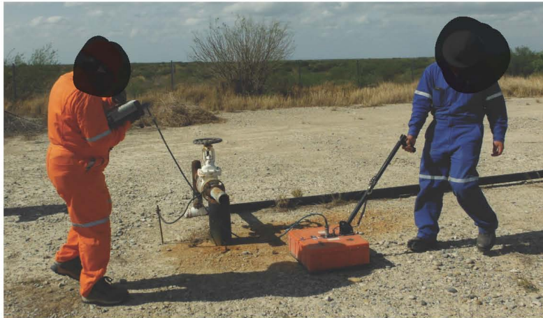
Fotografía 19. Escaneo con geo-radar GSSI-SIR 3000
