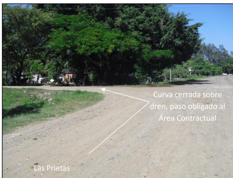
Imagen III.e-6.- Curva en puente sobre dren. ( 22^{\circ}31'40 N / 97^{\circ}57'11 O).
