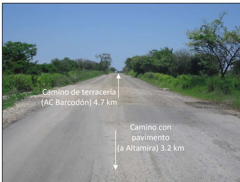
Imagen III.e-4.- Termina 3.2 km pavimentados e inician los 4.7 km de mantenimiento a la terracería. (22°29'54 N / 97°58'59 O).
