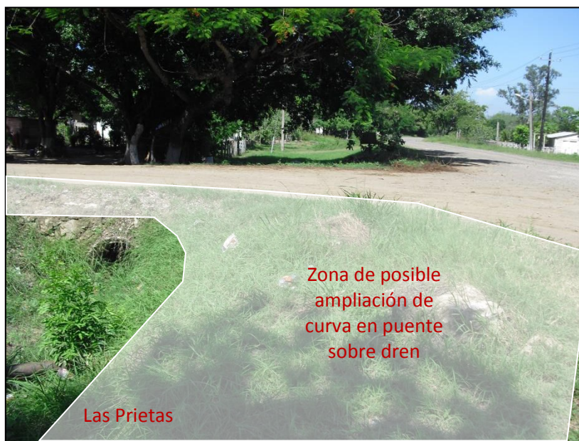
Imagen III.a-7.- Zona de posible ampliación.
