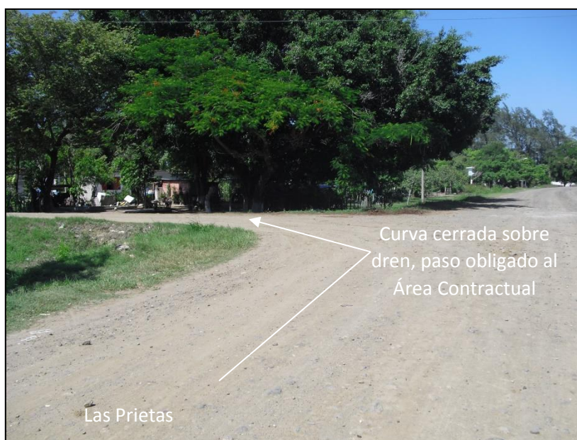
Imagen III.a-6.- Curva en puente sobre dren. (22°31'40 N / 97°57'11 O).
