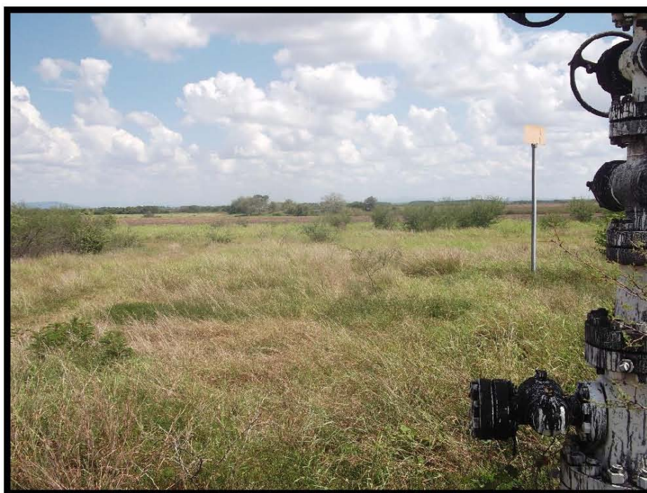
Fotografía 8.1.3.1-6.- Salida de LDD del Pozo Barcodón 138 en las coordenadas UTM WGS84 X: 607285 Y: 2498407.
